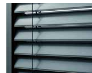
Die Lamellen des Raffstores lassen sich stufenlos schräg stellen
